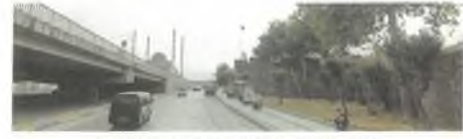
Şekil 22. Reşadiye Kavşağı ve Kale surları arasındaki mesafe
