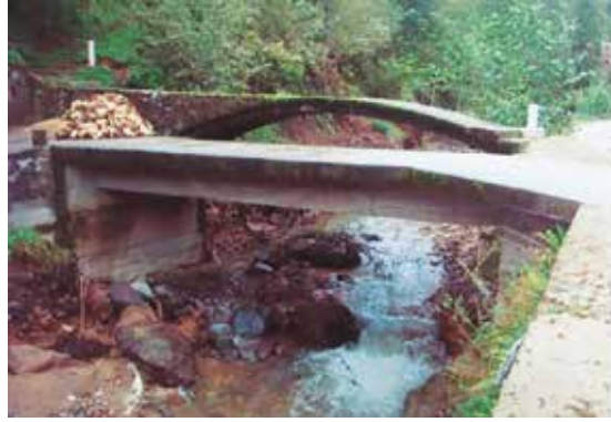
Sürmene Ormanseven'de Hatalı İnşa Edilen Bir Köprü
