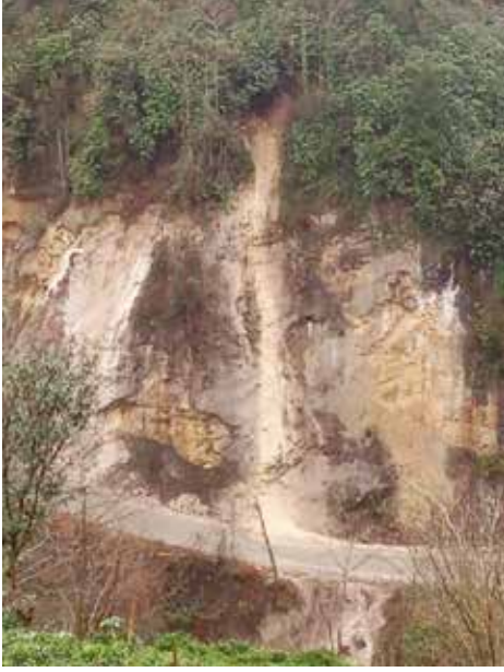
Of İlçesi Bölümlü Mahallesi'nde Yamaçtan Kopan Kaya
