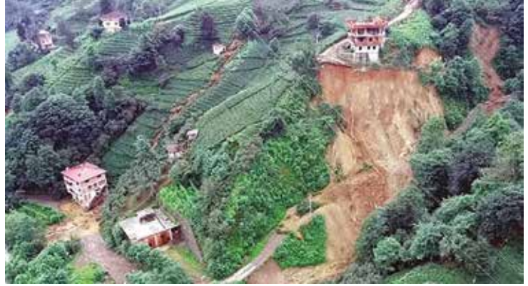
Hayrat/Dumlusu Mahallesi'nde Meydana Gelen Heyelan
