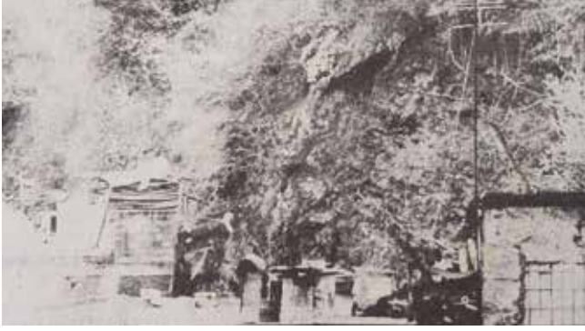
1983 Senesinde Esentepe Mahallesiinde Kaya Heyelanı Meydana Gelen Yer
