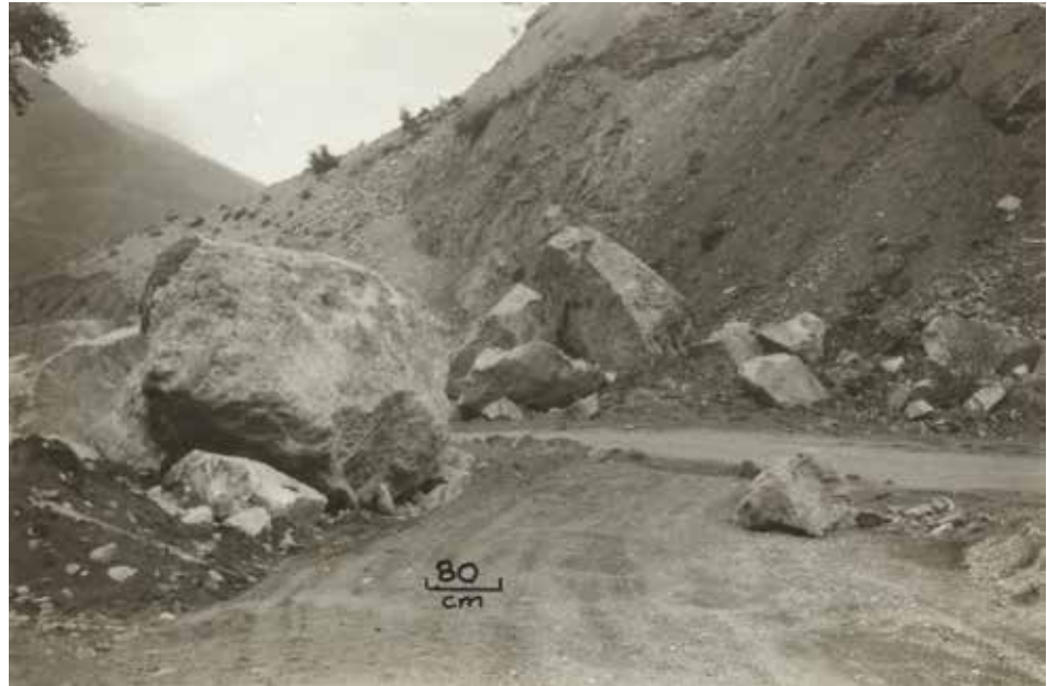
Çatak Heyelanında Düşen Kaya ve Malzemeler
