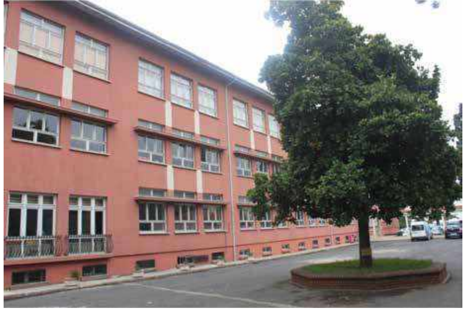
Trabzon Lisesi Güncel
