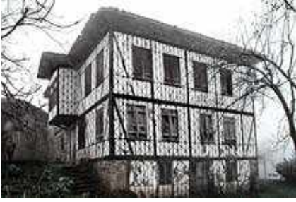
Muskalı dolma duvar. (Aksu, Sürmene - TRABZON)
