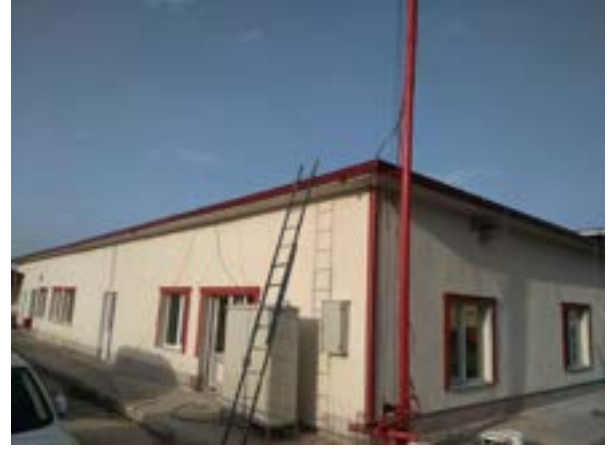
Maçka İtfaiye binası çatı tadilatı yapıldı.
