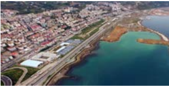
1.Etap Trabzon Merkez Beşirli Sahili Dolgu Alanı Tahkimat İnşaatı Devam Ediyor. Sözleşme Bedeli: 24.461.273,00TL
