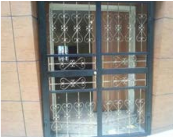
Belediyemizin ihtiyaç duyulan çeşitli birimlerine kapı montajı yapılmıştır.
