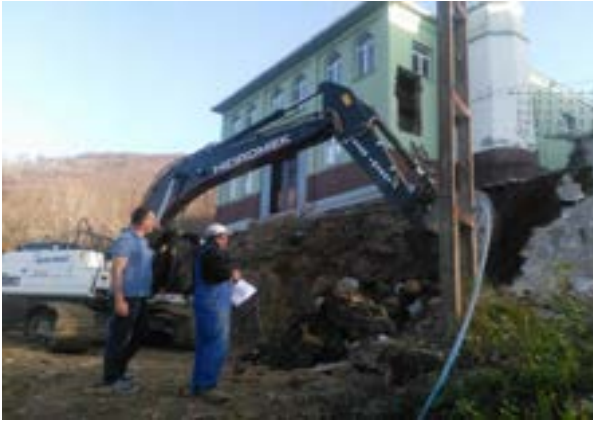
Düzköy İlçesi Yenimahalle camii
