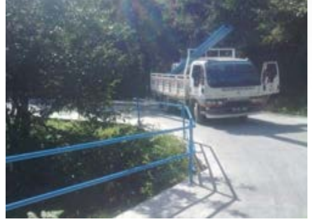
Muhtelif ilçelerde korkuluk yapılması,tamiri ve boyanması
