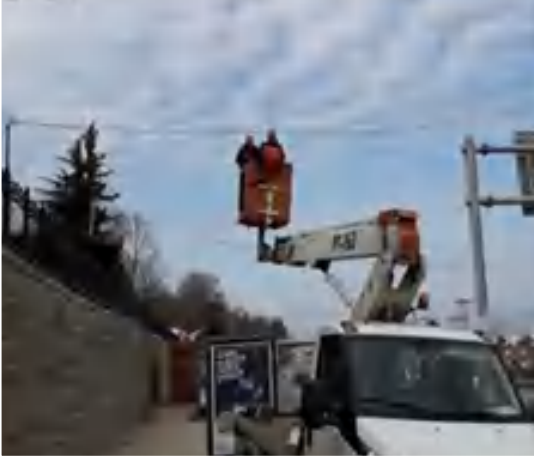
Belediyemiz ekiplerince şehrin muhtelif yerlerinde yapılan aydınlatma çalışmaları
