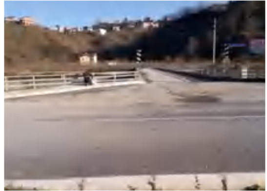
Devlet Sahil Yolu Toklu Üstgeçidinin kaynaklık tamiri ve boyası yapıldı. Şehrin muhtelif yerlerinde ihtiyaç duyulan köprü korkuluklarının tamiratları yapılarak boyatılmaya devam edildi.
